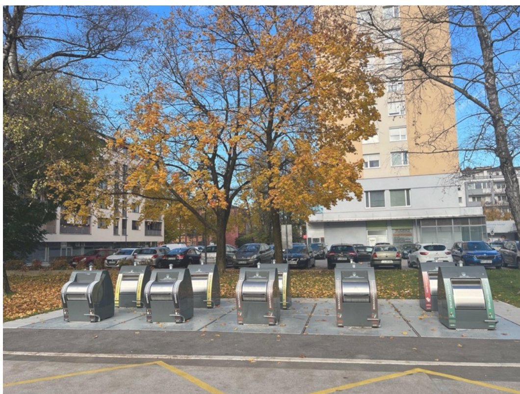
Slika 9: Podzemna zbiralnica na Šaleški cesti (STA)
