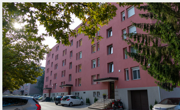
📷 Tomšičeva cesta 39-41-43, Velenje, saniran objekt (leto sanacije 2020, sanirana fasada, hidroizolacija, ograje, strelovodi in stavbno pohištvo) (Andraž Roškar)
