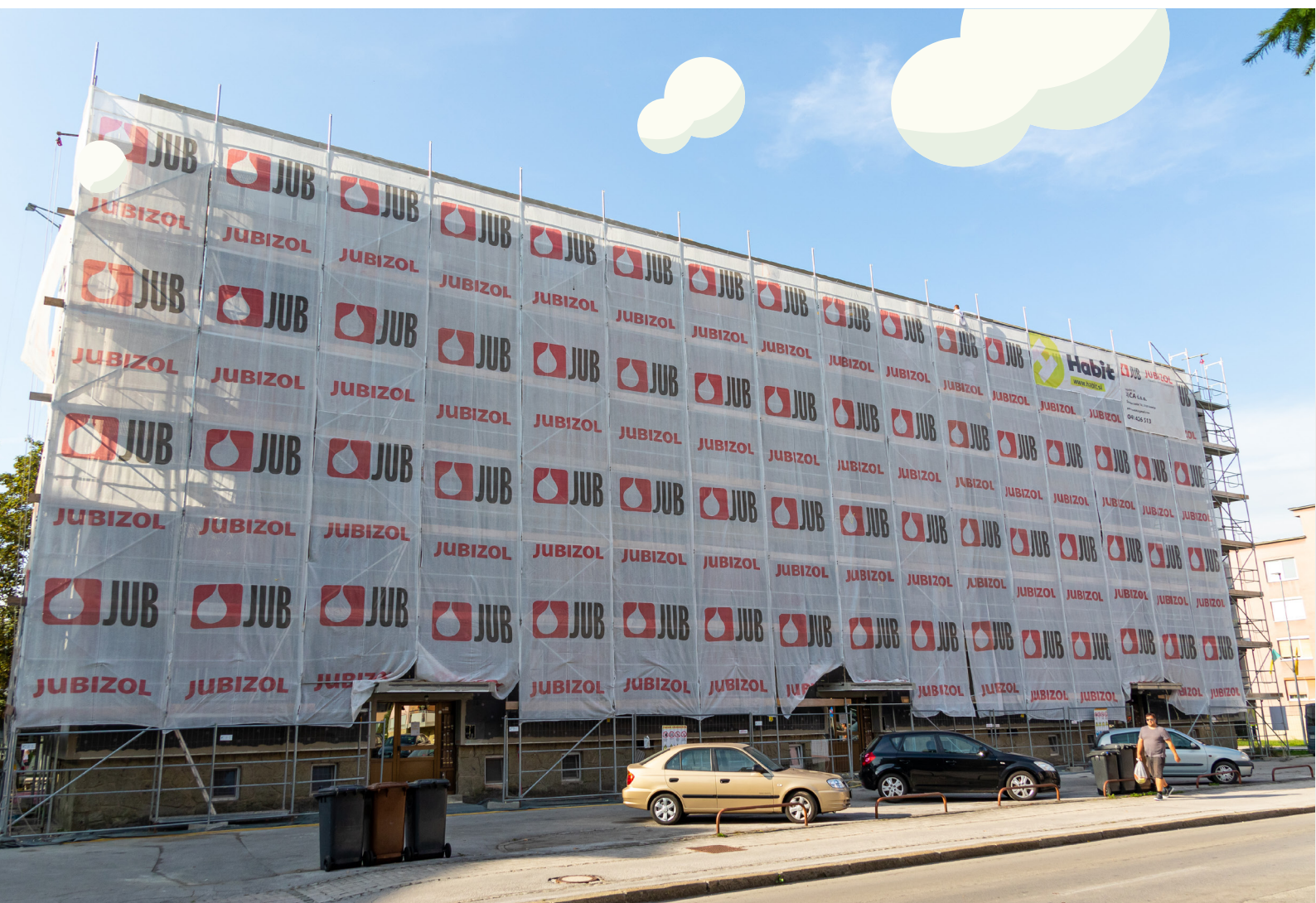
📷 Sanacija bloka na Tomšičevi cesti v Velenju (Andraž Roškar)
