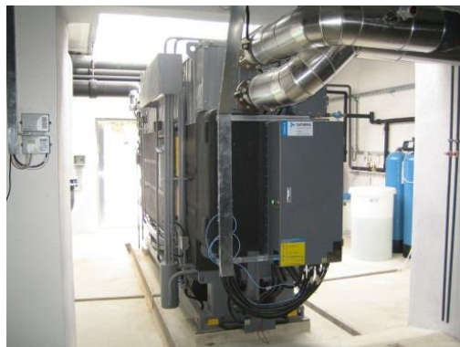
Slika 16: Absorpcijska hladilna naprava
