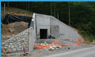
gradnja vodohrana Hrastovec
