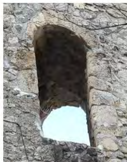
Slika 97: Prehod skozi severni vogal stolpa.
