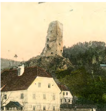
Ruševine pred obnovo, ko so imele najmanjšo stavbno maso.
