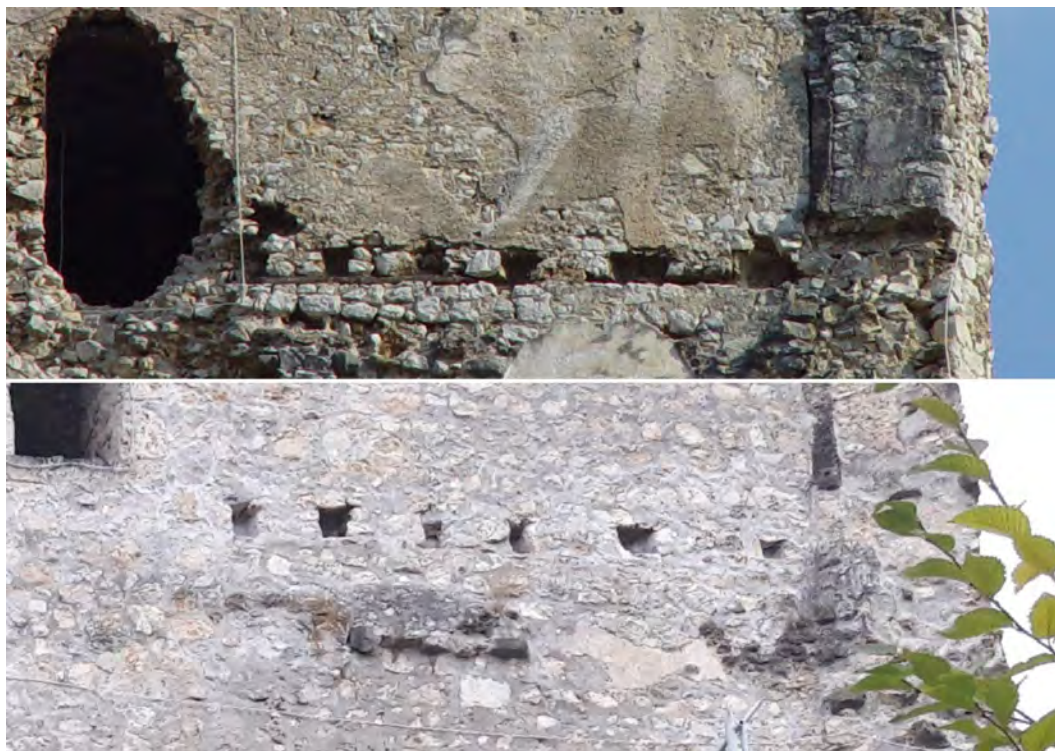
Grad Šalek – isti detajl zidu pred in po obnovi (foto Rok Poles)
