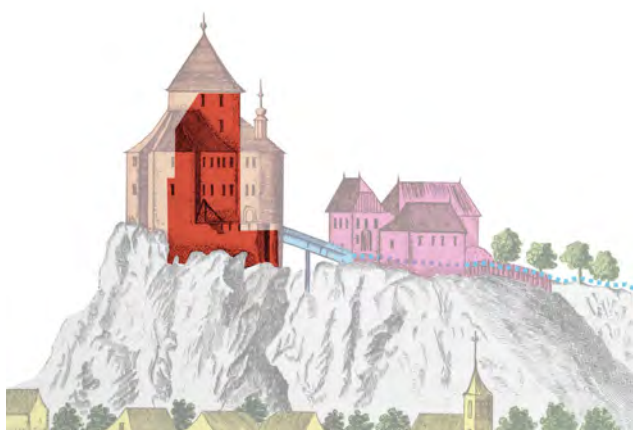
Obseg grajenega tkiva, ohranjen kot ruševina gradu Šalek.
