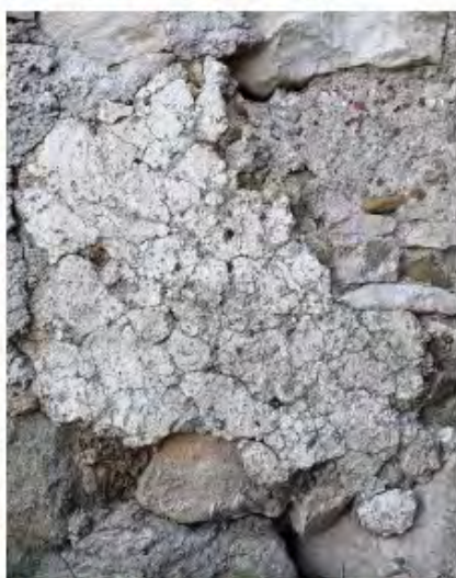
Slika 99: Beli apneni omet na dvoriščni fasadi stolpa.
