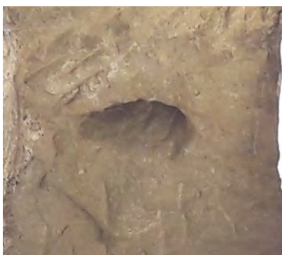
Preklada iz peščenjaka nad lino v pritličju stolpa, z luknjo za kovinsko palico
