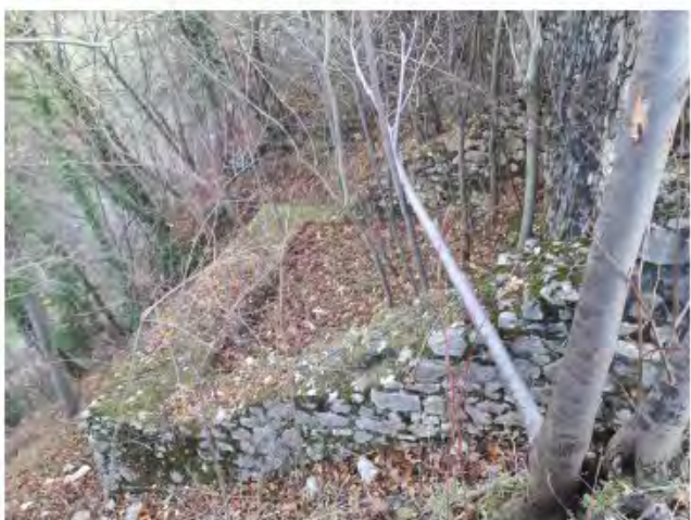
Slika 90: Temelji stavbe, naslonjene na severno stran obrambnega zidu
