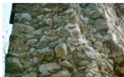
Slika 100: Zidava tipa opus emplecton, jasno vidna pred rekonstrukcijo: debeli zid je troplasten. Najprej so postavili dva vzporedna zidova, prostor med njima pa napolnili s polnilom – kamni in peščenim drobirjem, dodali so živo apno in ga pogasili z vodo – tako se je polnilo na mestu spremenilo v monolitno konglomeratno jedro, ki pa je le slabo povezano s kamni v obodnih stenah, ki zato lokalno odstopajo in odpadajo.
