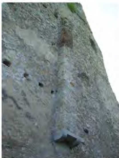
Slika 93: Dimnik na vzhodni fasadi stolpa.
