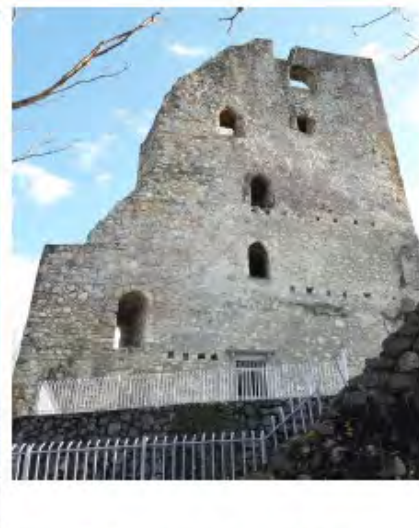
Slika 82: Zunanja fasada – zahodna
