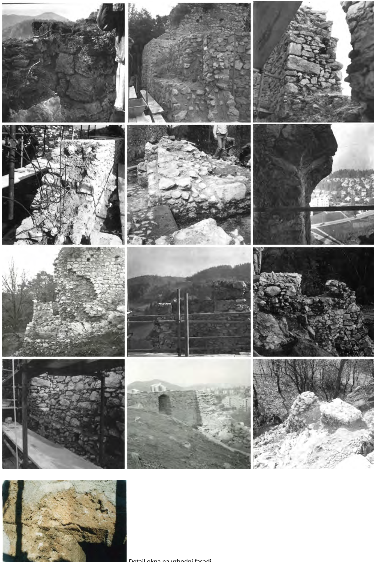
Detajl okna na vzhodni fasadi
