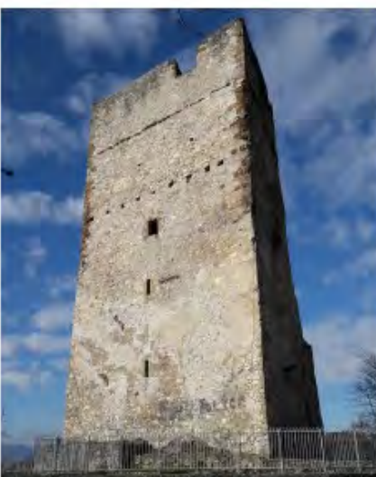
Slika 81: Zunanja fasada – južna
