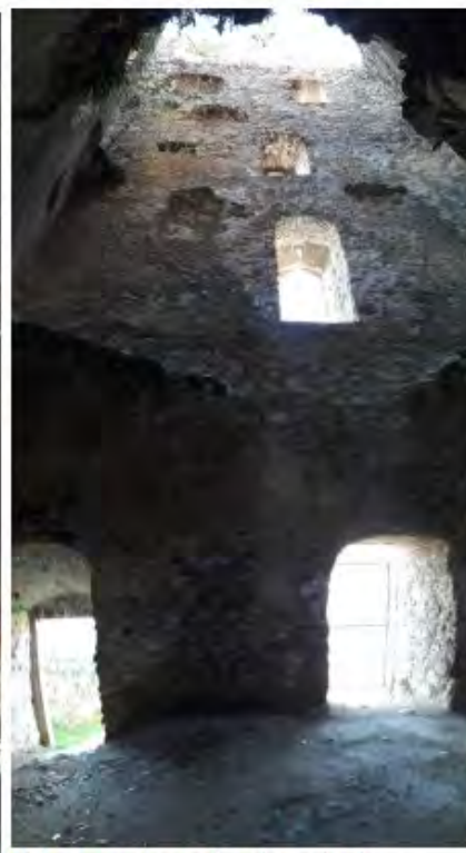
Slika 85: Notranja fasada - zahodna: komunikacije so bile usmerjena proti notranjemu dvorišču. Dve zgornji okni sta opremljeni s sediljama.
