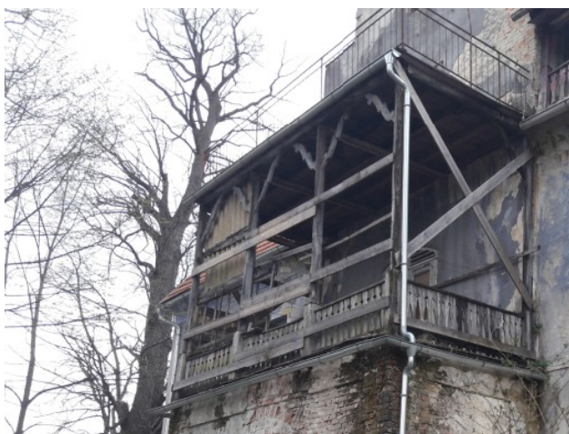
Dotrajani altan bo najbrž potrebno natančno dokumentirati in izdelati na novo, morda v prvotni varianti – s prostim pritličjem, kar bi omogočilo prezentacijo prvotnega vhoda v objekt in naravno osvetlitev osrednje veže v pritličju.
