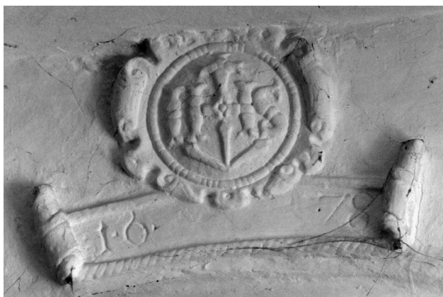
Kamnita okrogla kartuša z zavojki in bisernim astragalom okoli Jezusovega monograma IHS ter treh žbljev, pod kartušo napisni trak z letnico 1·6·78. Zdi se, da je novejši strop prekril vrhni del kartuše – sondirati, ali je bil strop primarno višje, morda samo vidni tramovi brez spodnjega dedščičnega oboja (opaža)
