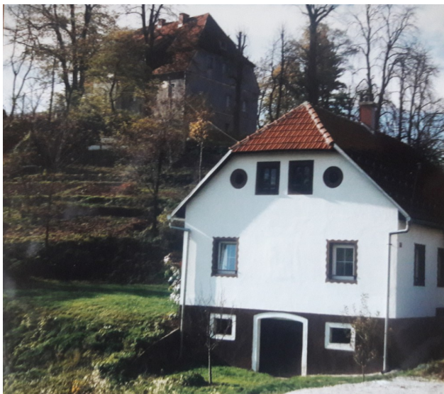
Mala hiša pod graščino pred prenovo
