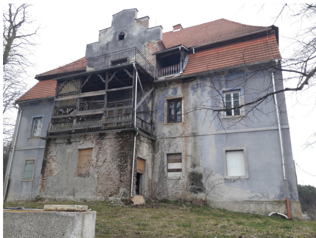
Zahodna fasada. Loža desno od stopničastega čela je naknadna in se ukine.
