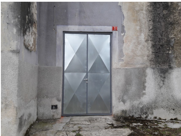
Recentna vrata so zgolj funkcionalna, fasadno pohoštvo bo moralo biti novo. Naslov Lipa 1 dobro kaže na prvenstvo objekta v okolju, lokacija ploščice pa ni ustrezna.
