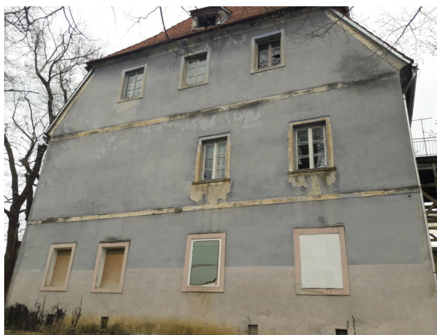
Severna fasada. Neusklajeni rastri oken pričajo o tem, da stavba ni nastala naenkrat.
