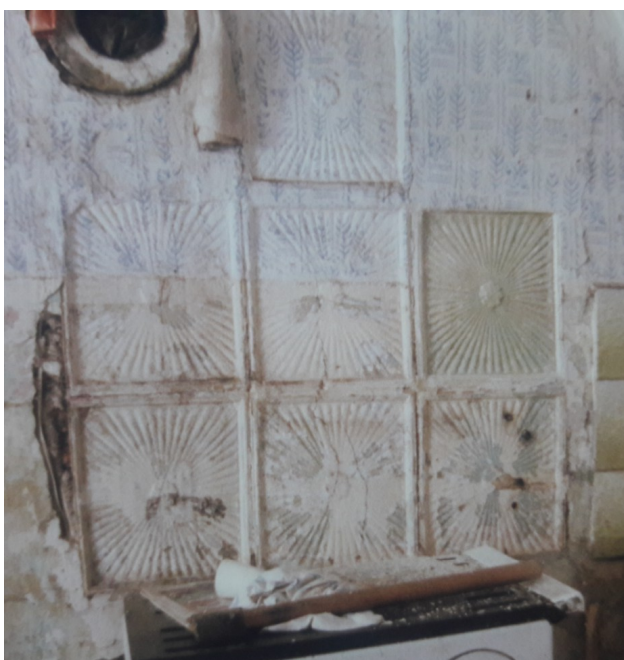
Pečnice, ohranjene še 'in situ' na objektu - prebeljene
