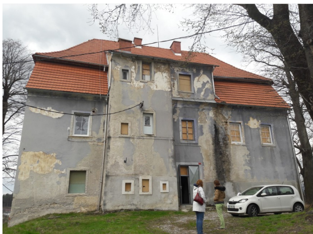
Vzhodna – dovozna fasada. Dozidani rizalit s stranišči je zakril naravno osvetlitev notranjega stopnišča.
