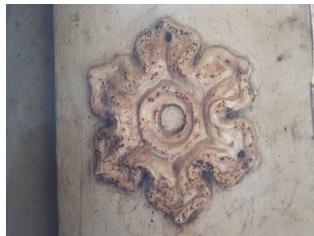
Kamnita okrogla kartuša z zavojki in bisernim astragalom okoli Jezusovega monograma IHS ter treh žbljev, pod kartušo napisni trak z letnico 1·6·78. Zdi se, da je novejši strop prekril vrhni del kartuše – sondirati, ali je bil strop primarno višje, morda samo vidni tramovi brez spodnjega dedščičnega oboja (opaža)
