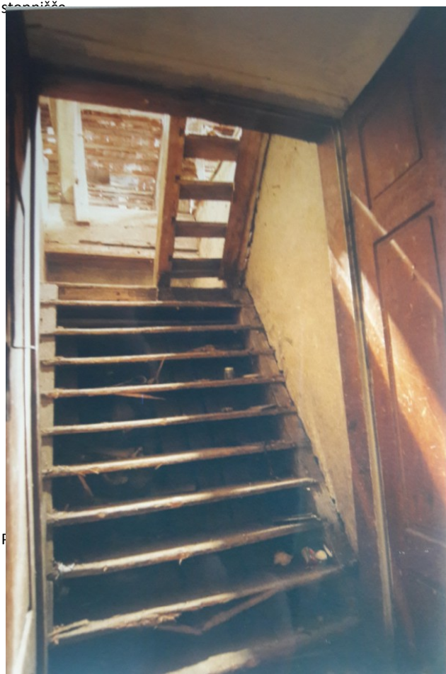
Lestev na podstrešje omogoča samo revizijski dostop, če bi se podstrešje želelo javno uporabiti, je potrebno izdelati novo stopnišče.
