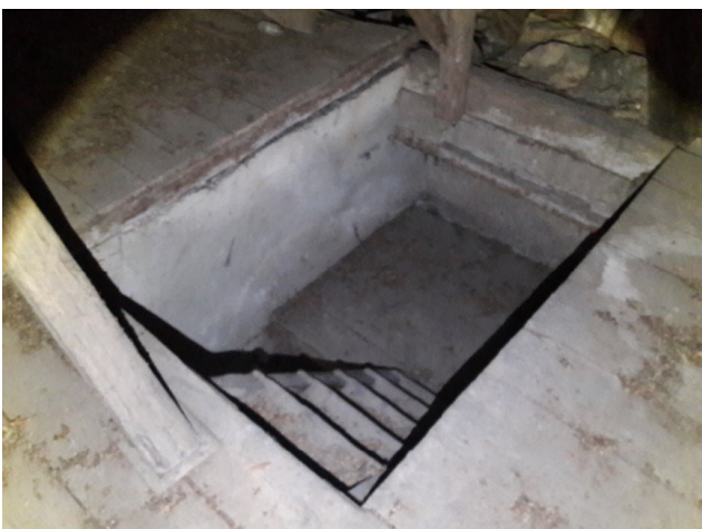
Lestev na podstrešje omogoča samo revizijski dostop, če bi se podstrešje želelo javno uporabiti, je potrebno izdelati novo stopnišče.
