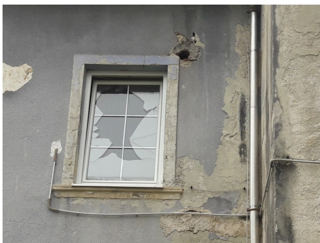
Okna imajo različne okvirje, nekateri so samo fingirani v ometu – tole okno ima kamnito samo polico, ki pa je drugače profilirana kot pri oknu levo.
