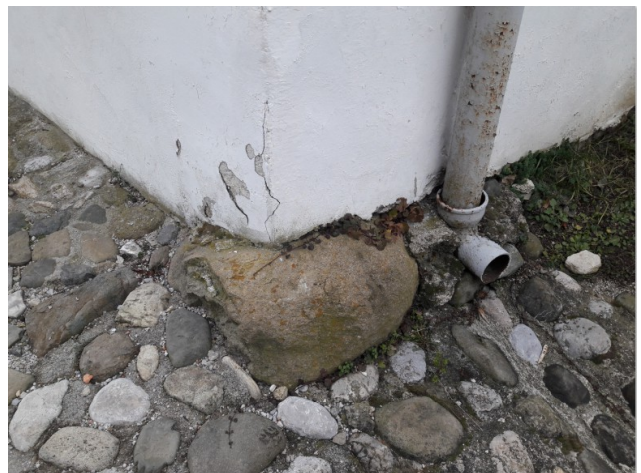
Bržčas ostanek kamnitega odbojnika, ki je ščitil vogal stavbe s stopničastim čelom
