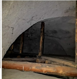
Grebenasti obok spodnje etaže rondele z osmimi enakimi polji, grebeni z osrednjega stebra se iztečejo v vrhove sosvodnic.
