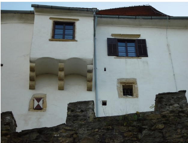
Slikoviti motiv severne fasade: konzolni izzidek in stara kletna okna z naoknicami
