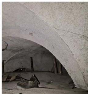
Grebenasti obok spodnje etaže rondele z osmimi enakimi polji, grebeni z osrednjega stebra se iztečejo v vrhove sosvodnic.
