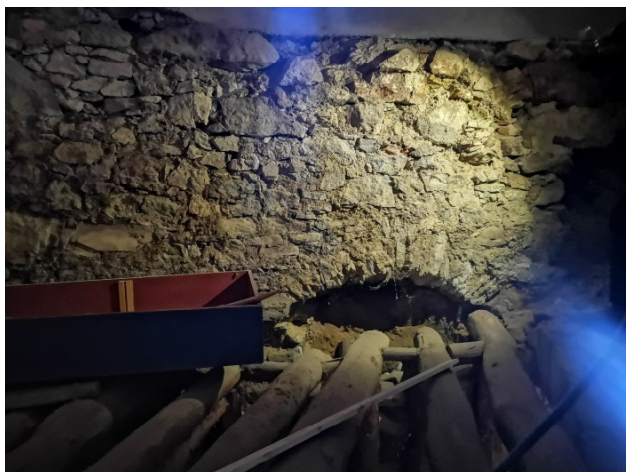
Vzhodna stena etaže pod hlevom z lokom nad zazidanim oknom
