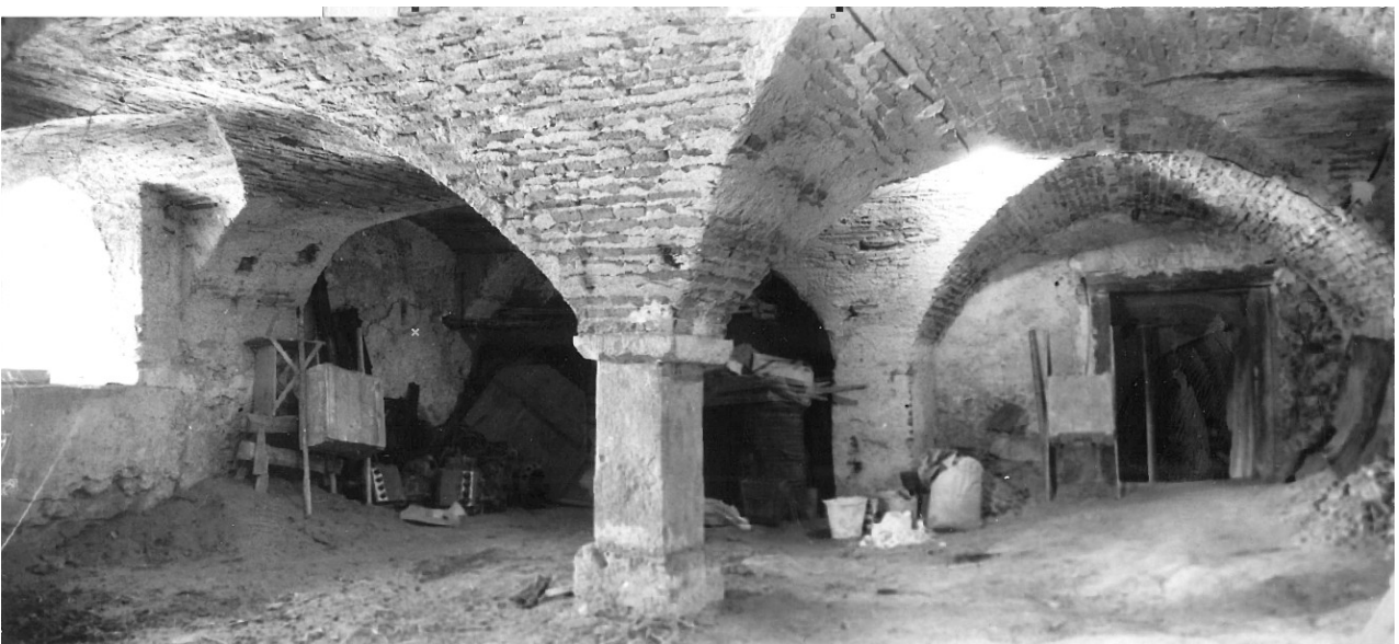
Cesarjev depo v kleti, foto Berk, ZVKDS OE Celje – posnetek sestavljen iz slik 3 in 7. Značilna obdelava obokov z ostanki ulivanja v opaže.
