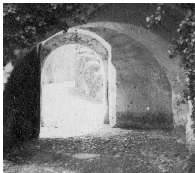
Enokrilna vrata vhodnega stolpa in posnet vogal vratnega ostenja na desni strani. Torej so sedanja dvojna vratna krila neavtentična ... Je bila prvotna ureditev torej enaka kot pri vratih v grajsko jedro? Veža je na sliki obokana, sedaj ima raven strop.
