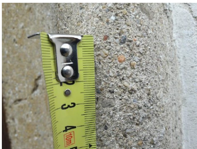
Okvirji so zidarsko izvedeni, drsani, z drobnim rečnim peskom.
