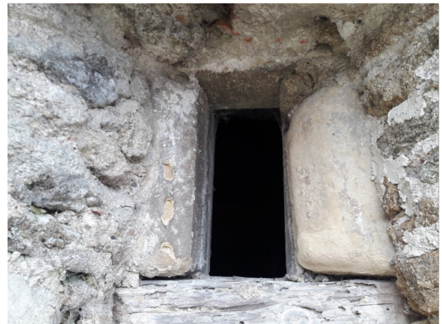
Na kamnitem okvirju line so še ohranjene sledi barve. Barva je služila kot dekor in zaščita kamna.
