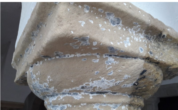
Ostanki barve na stebrih – je šlo v nekem času za renesančno shemo poslikave s temno pobarvanimi kamnoseškimi elementi in svetlo folijo zdov?
