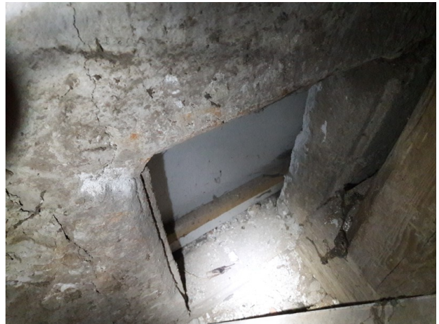
Enako okno na vzhodni = dvoriščni fasadi, ki ga je skrila streha arkadnega hodnika, severni del
