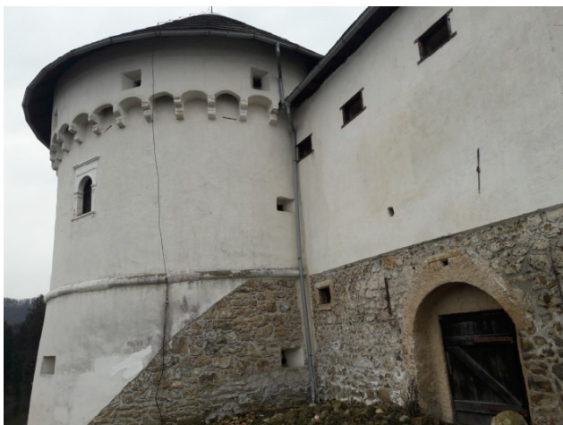
Rondela z novim vhodom iz 1966. Ni jasno, na osnovi česa je potegnjena meja med fugiranim in ometanim delom. Zakaj rvsaj ondel ni v celoti ometana?
