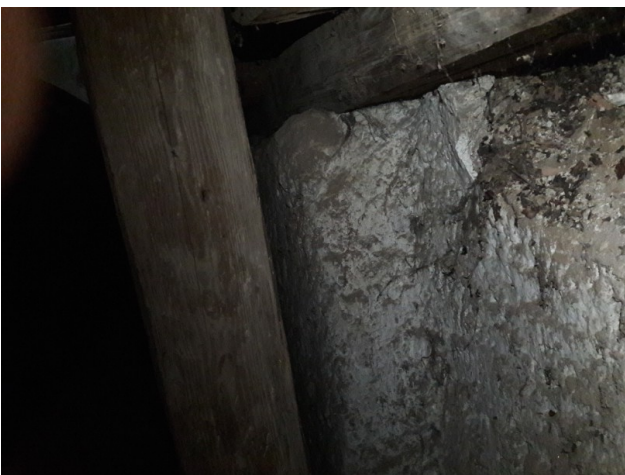
Zob na podstrešju, dvoriščna fasada zahodnega trakta, domnevno stik prve in druge gradbene faze.
