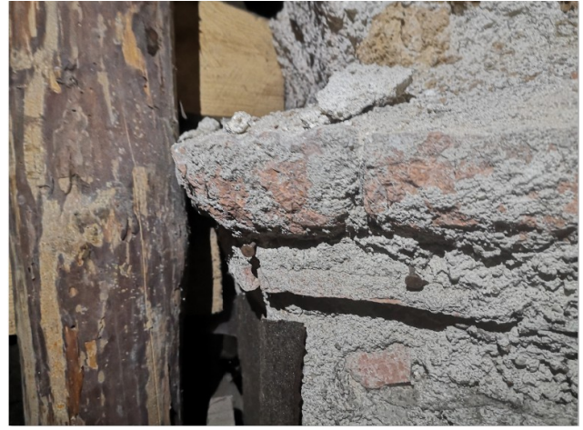
Z opeko izvedena osnova za profilacijo nosilnega stebra (za karnisni venčni zidec).
