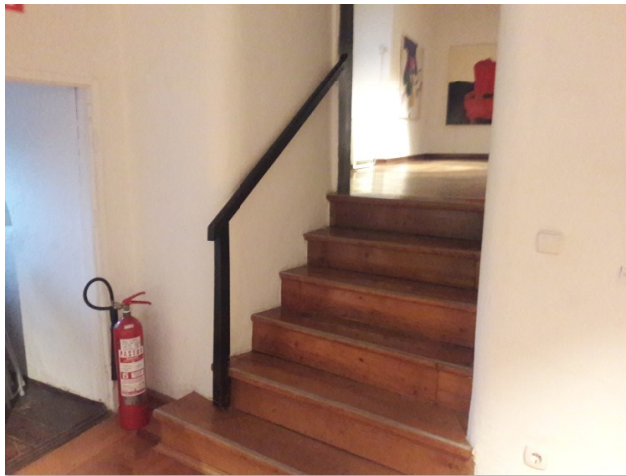
Ročaj stopnišča ni ustreznega profila (krožni profil ca 40 mm), segati bi moral 30 cm preko prve in zadnje stopnice.
