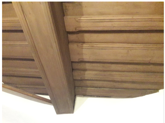
Profilirani lesen strop v pisarni direktorice
