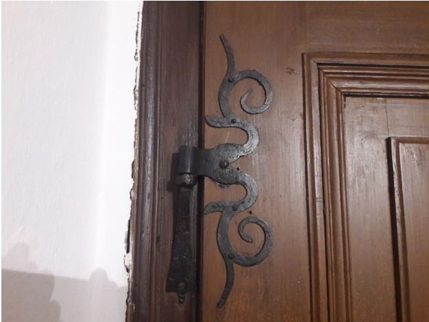
Kovano okovje / panti. Je tu ohranjena svetlejša rjava barva stavbnega pohištva, kakršna se vidi na starih slikah fasade?
