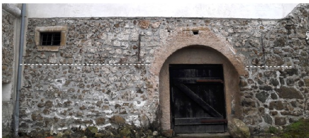
Rondela z novim vhodom iz 1966. Ni jasno, na osnovi česa je potegnjena meja med fugiranim in ometanim delom. Zakaj rvsaj ondel ni v celoti ometana?
