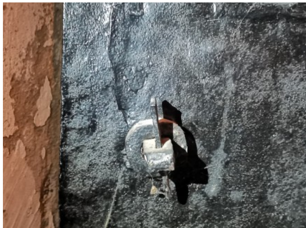
Zatič s podložkami in zagozdo: če se je zagozdo izvleklo, se je lahko vrata odprlo tudi, če so bila od zunaj zaklenjena z žabicami
