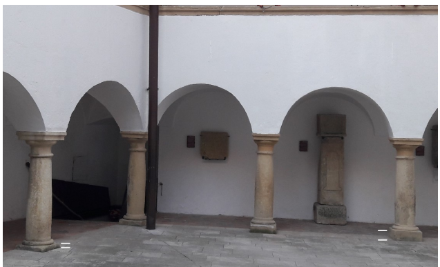
Različno visoka podnožja stebrov kažejo na spremembo (višanje) tlaka
