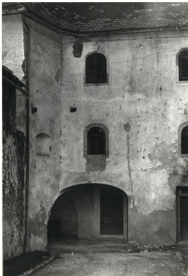
Vhodni stolp gradu z dvoriščne strani, foto Stopar, 1969, ZVKDS OE Celje. Preoblikovane odprtine, bobrovec, objekt levo višji za eno etažo.
