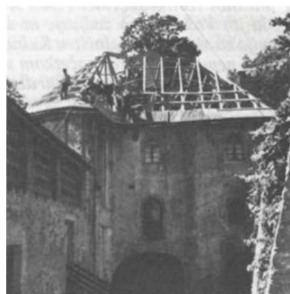
Na sliki je stavba 'garaža' višja za eno nadstropje, ki je bilo kasneje odstranjeno – kdaj, zakaj?
