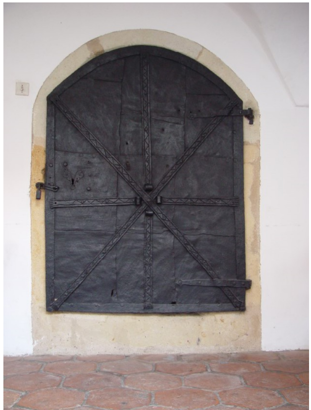
Segmenti portala so podloženi z opeko. Že primarno nenatančna izvedba (navadno so gotski kamnoseki bolj precizni) ali kasnejši poseg (sprememba prvotno šilastega profila v polkrožnega?)
