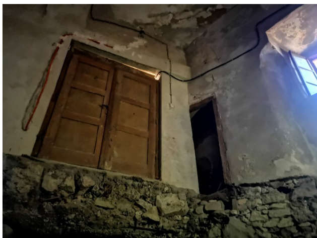
Stensko nišo hleva delno prekrije stena. Posneti vogal pri oknu.
