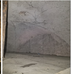
Grebenasti obok spodnje etaže rondele z osmimi enakimi polji, grebeni z osrednjega stebra se iztečejo v vrhove sosvodnic.
