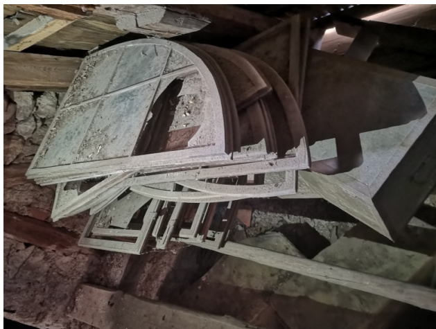
Zastekljeni paneli za zapiranje arkadnih hodnikov
