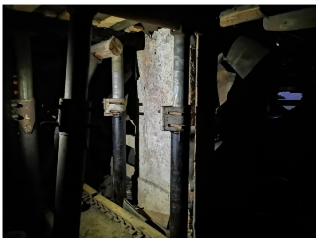
Prvi nosilni stlop, odvit iz strešne lepenke
