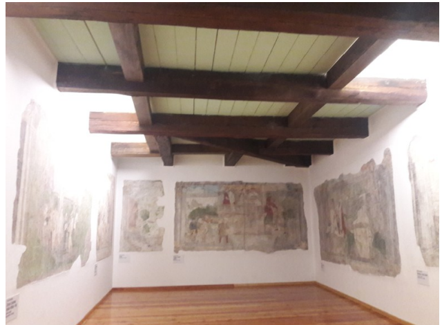
Severni del prostora, pod balkonom
