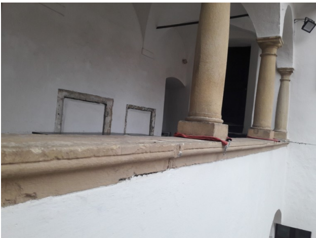
Profilirana kamnita polica parapeta hodnika v nadstropju
