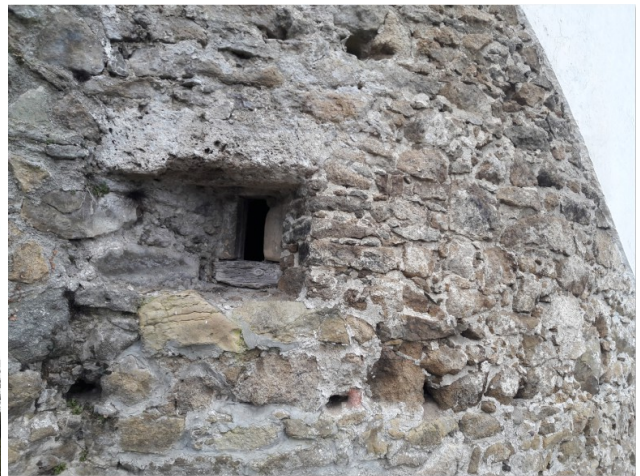
Severna strelna lina z močno preklado iz lehnjaka in brunčnice (sledi okroglih gred za zidarske odre) pod in nad njo
