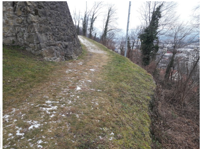
Na najbolj izpostavljenih (strmih) delih je podzidana tudi pot okoli gradu.
