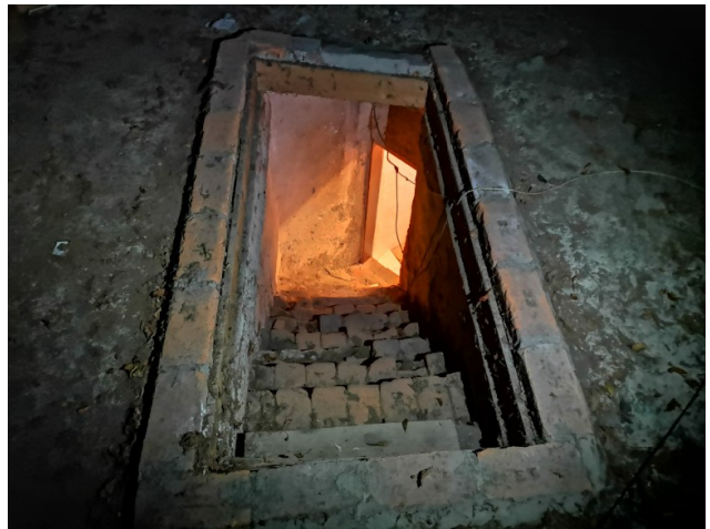
Vhodni stolp – dostop na podstrešje
