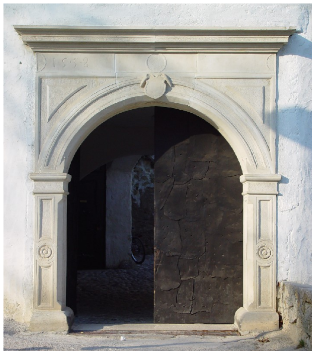
Portal po prenovi: kosi so različno sestavljeni glede na original, sklepnik je poenoten s preostalim profilom.
