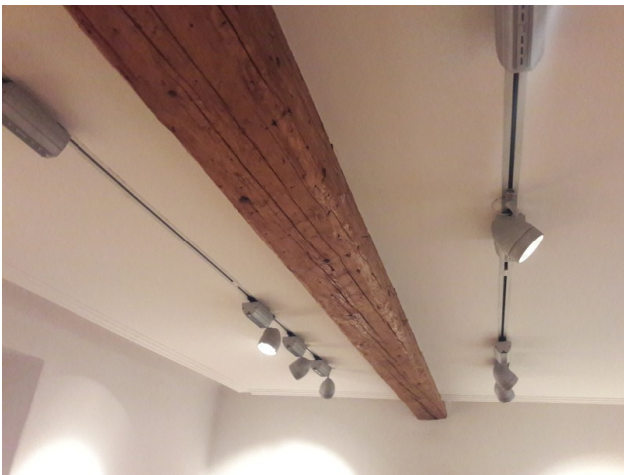
Tram in spuščeni strop v galeriji
