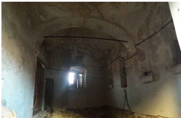
Oproga nosi dve poli plitvega kapastega oboka.
