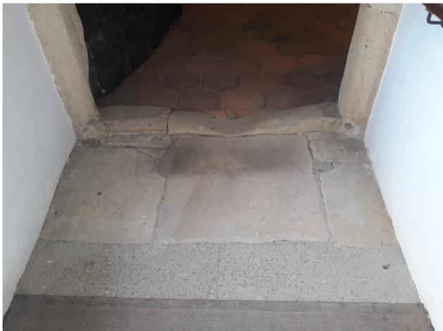
Tlak pred vhodom. Portal ne počiva na pragu niti ne gre do tlaka – nenavadno. Najbrž je bil tlak dvorišča zgodnejših gradbenih faz gradu precej nižji (veža, vratarnica, obe 'kleti' zahodnega trakta) in je bil tudi portal vzidan niže.
