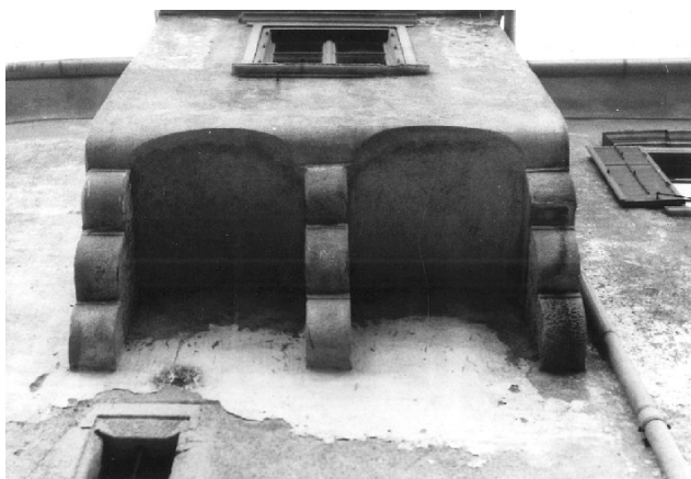
Izzidek na treh trojnih konzolah na severni fasadi, foto Stopar, poleti 1968, ZVKDS OE Celje.
