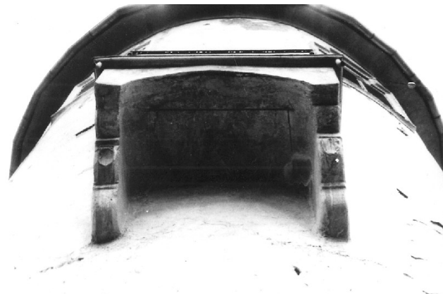
Konzole balkona, foto Stoparj, poleti 1968, ZVKDS OE Celje. Tudi na desni konzoli je bil ščitek, do leta 2019 povsem uničen in takrat rekonstruiran ob obnovi balkona.
