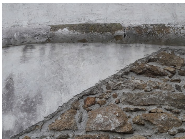
Kamnit, prebeljen vmesni polkrožni zidec rondela.
