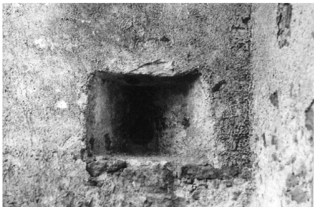
Strelna lina v rondeli, foto Stoparj, ZVKDS OE Celje, poleti 1968. Rondela je enotno ometana, danes je ometano samo ostenje line, preostalo široko fugirano. Ometati tudi ta del stene?
