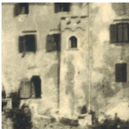
Ob sedanjem službenem vhodu je stal stolpič. Kdaj in zakaj so ga odstranili, ni znano. Zazidali so tudi vrata v zahodni fasadi v pritličju.
