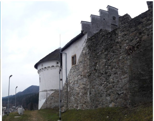
Pasus proti rondeli: nelogičen diagonalen stik ometanih stavb in obzidja - stavbe bi morale biti v celoti ometane do tal.
