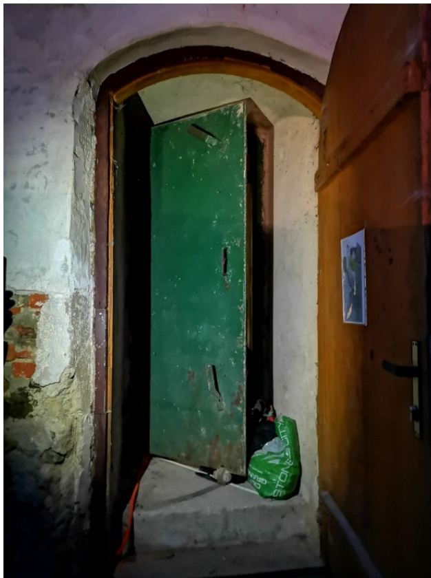
Vrata v klet okroglega stolpa – notranja bunkerska / zakloniščna (na kolescu) in zunanja lesena, obita s pločevino
