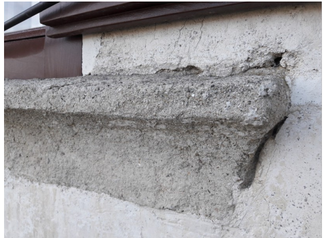
Zidarsko izdelani / iz malte domodelirani profili / okvirji oken na južnem delu zahodne fasade posnemajo kamnite člene.
