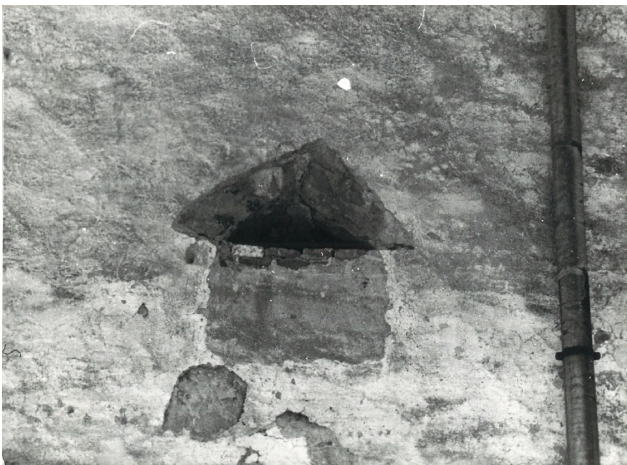
Foto Berk, ZVKDS OE Celje. Trikotna odprtina na severni fasadi.
