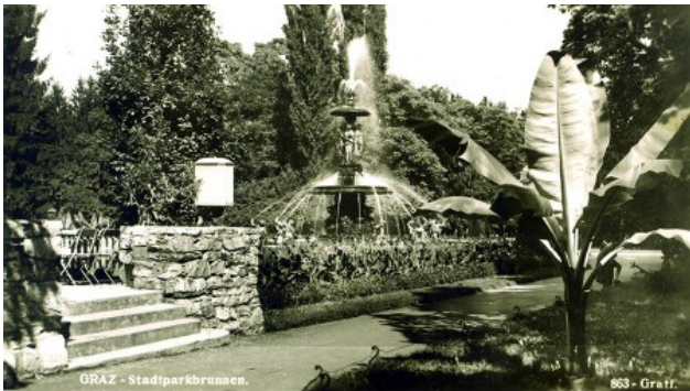
gradnja opornih zidov z lomljencem, bananovec
