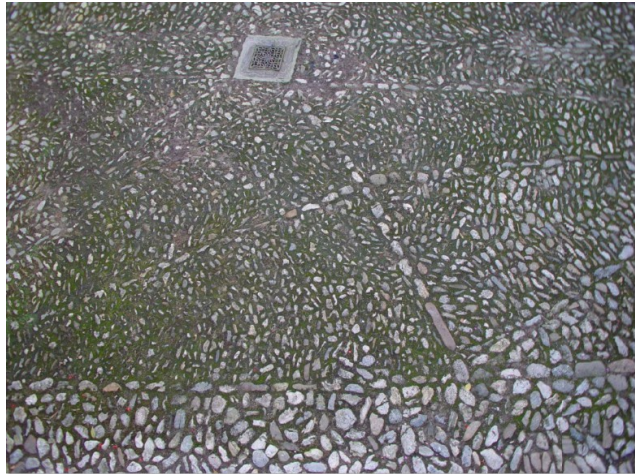
Nekdanji tlak iz mačjih glav (rečnih oblic)
