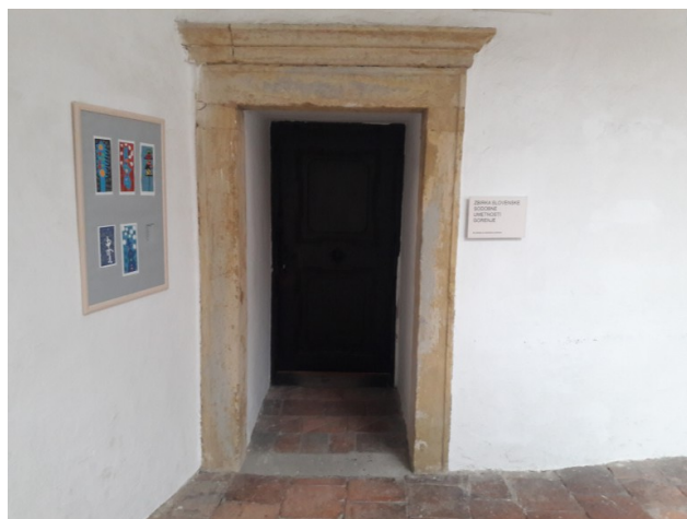
Portal v sobo 11. Interpolacija pod preklado - povišanje?
