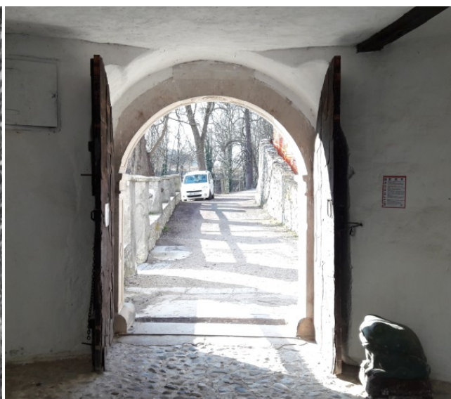
Isti pogled danes: dvokrilna vrata raven strop, desno dodaten usek v ostenju, da vratno krilo ne udarja v rob ... Neavtentična ureditev.
