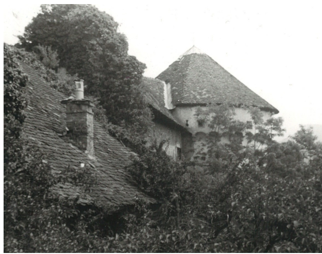
Velenje – grad, foto Curk, 1957, ZVKDS OE Celje. Dimnik nekdanjega steklenjaka, ključasta strelna lina na konzolnem vencu rondela.
