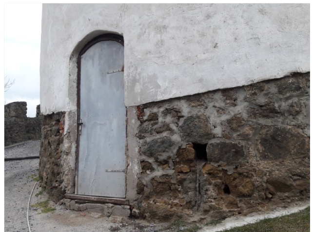
Vhod v klet okroglega stolpa – klet je bila prvotno dostopna samo od znotraj, z vrha. Anahrona vrata. Obdelati?
