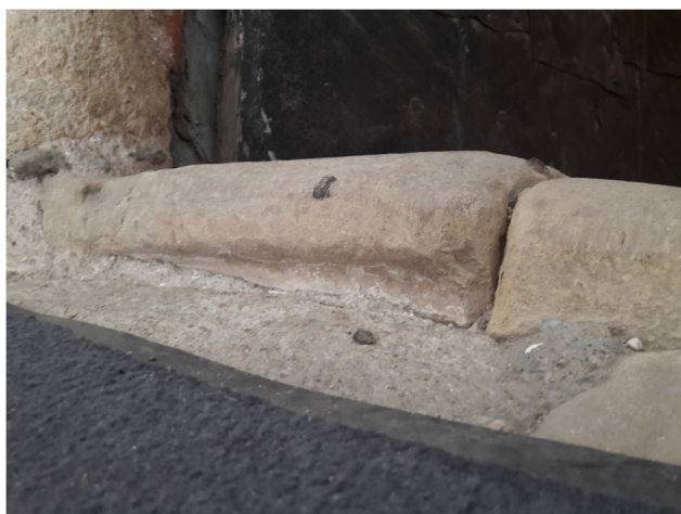
Kot del praga uporabljena profilirana spolija.
