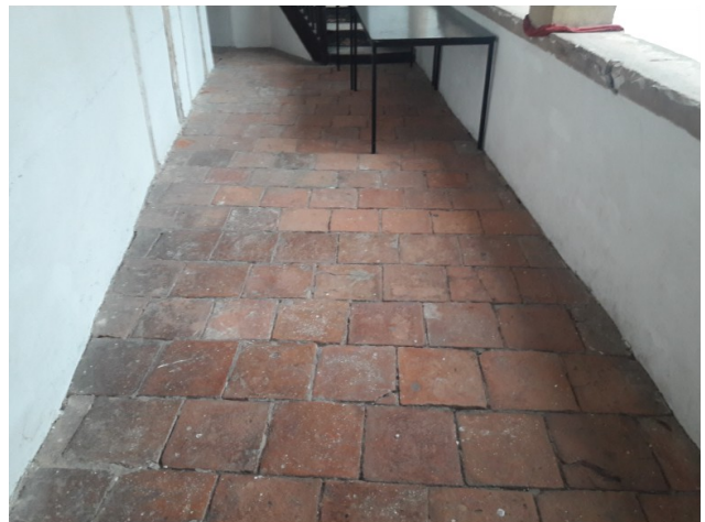
Opečni tlak vzhodnega hodnika
