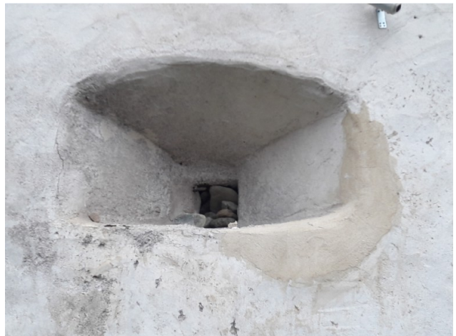
Strelnica vhodnega stolpa
