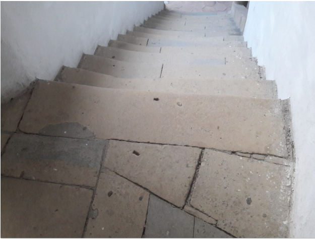
Vdolbini na vrhu stopnic za fiksiranje nekdanje zasteklitve
