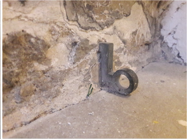
Zanke za palice, ki so držale tekače preko stopnic
