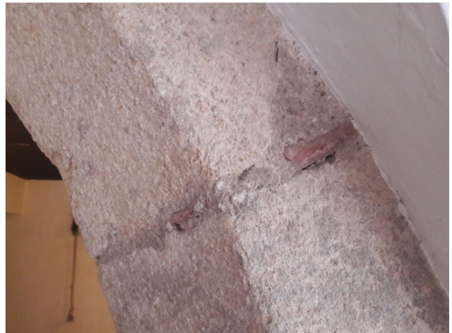
Segmenti portala so podloženi z opeko. Že primarno nenatančna izvedba (navadno so gotski kamnoseki bolj precizni) ali kasnejši poseg (sprememba prvotno šilastega profila v polkrožnega?)
