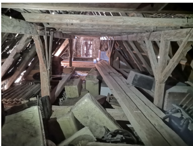
Podstrešje nad stavbo zahodno od rondele
