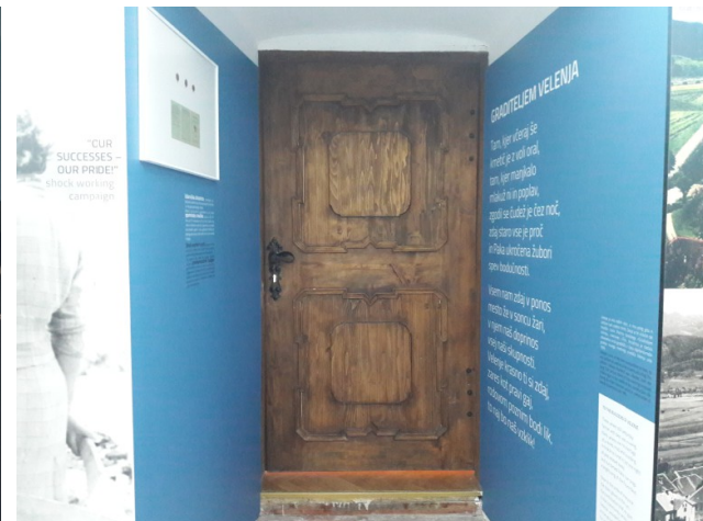
Vratno krilo z izstopajočo obdelavo – poenotiti z ostalimi (pokrivni premaz lesa)?
