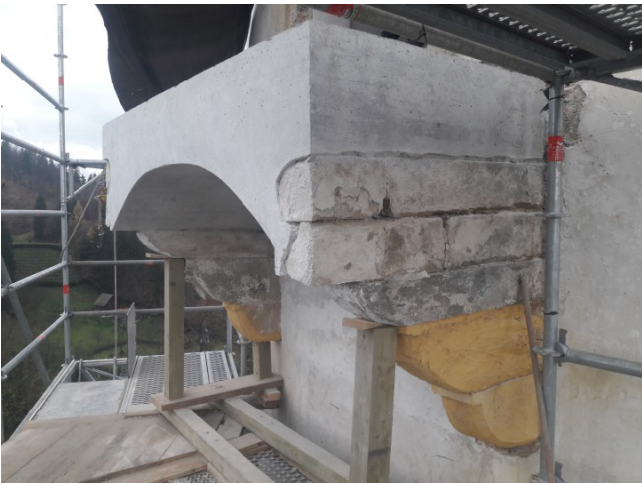
Balkon po zalitju nove plošče z obokom vred in grobo domodelirano desno konzolo – pred modliranjem ščitka in beljenjem betonskega dela.
