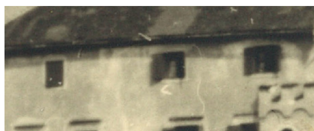
Podstrešna okna, ki so zdaj slepa in zazidana, so bila funkcionalna in opremljena z naoknicami (polkni).
