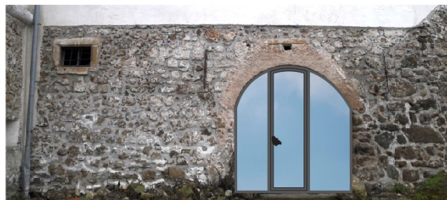
Kamniti okvirji okna imajo poznogotsko profilacijo (ajdovo zrno), vendar se vidi, da so kamni sekundarno zloženi na to pozicijo: profilacija preklade je predolga, prekratka polica ima luknjo za mrežo na sprednji strani.
