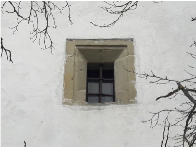
Okna zunanjega stavbnega plašča
