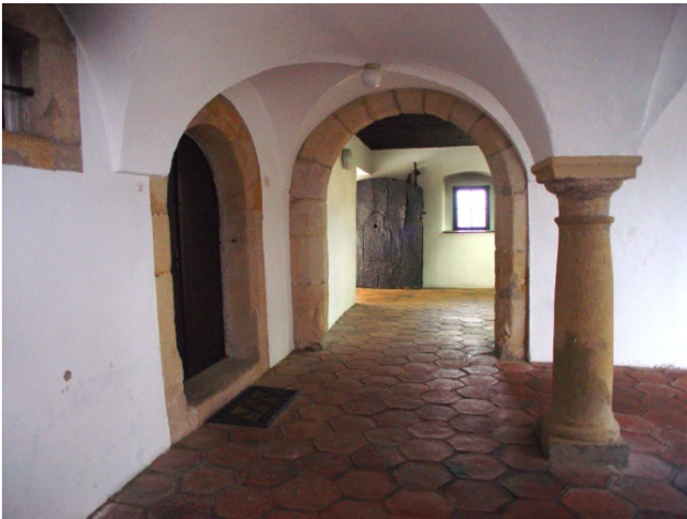
Pogled z dvorišča proti vhodni veži. Lok portala je zložen iz mnogo segmentov – nenavadno v primerjavi z drugimi portali
