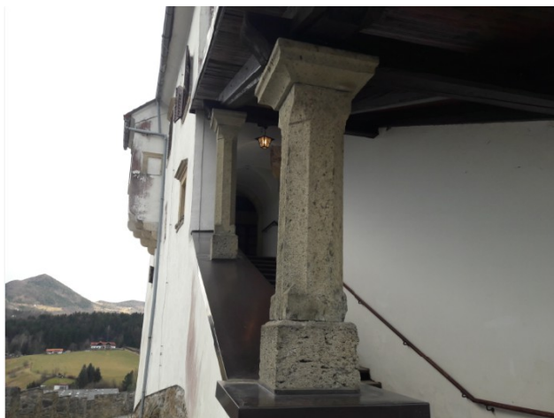
Stebra nadstreška nad stopniščem sta iz zelenega vulkanskega tufa
