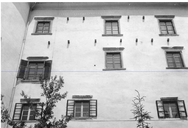
28. 5. 1990, foto Gričar, ZVKDS OE Celje. Kasetna okna = notranja in zunanja zasteklitev.
