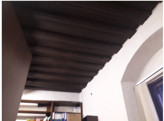
Profilirani lesen strop v pisarnah kustosov
