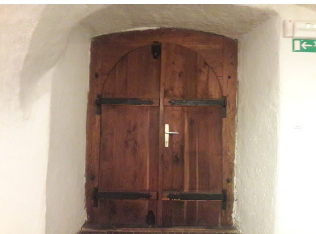
Vrata od znotraj. Diskrepanca med okovjem in kljuko.
