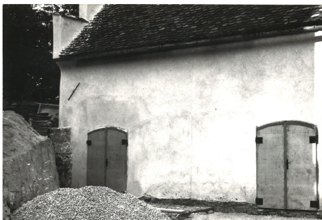
Obnovljen prizidek na grajskem dvorišču, foto Stopar, ZVKDS OE Celje, 1969. Vhoda v Rudarsko zbirko in Mastodonta sta brez nadstreškov. Kdaj in zakaj sta bila dodana? Streha je bobrovec, sedaj skodle.
