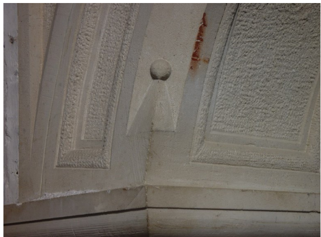
Posneti rob loka se konča še na gotski način - na trikotno 'ajdovo zrno'
