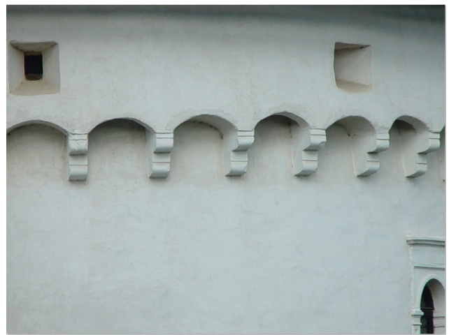
Detajl konzolnega venca
