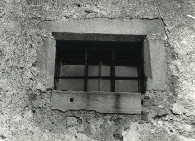
Okno kletne etaže ob rondeli, foto Stopar, poleti 1968, ZVKDS OE Celje. Viden je omet, danes je območje samo fugirano.
