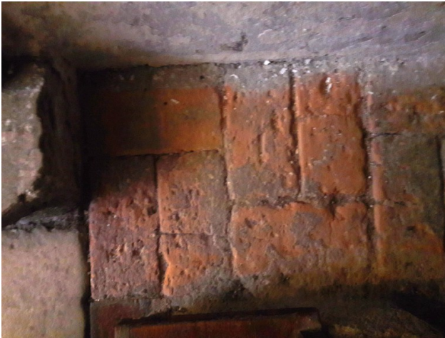
Opečni tlak prehoda ob stopnišču
