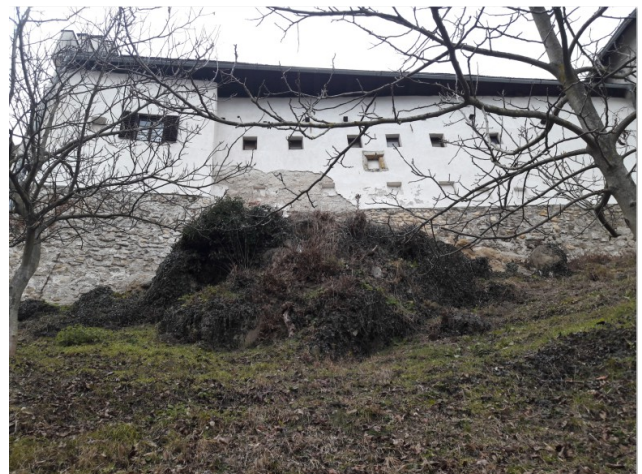
Objekt vzhodno od rondele: zazidana ali fiktivna okna?
