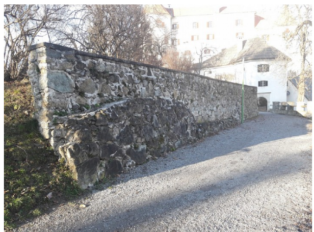
Severni zid spodnjega parterja – zaporedje večih gradbenih faz.
