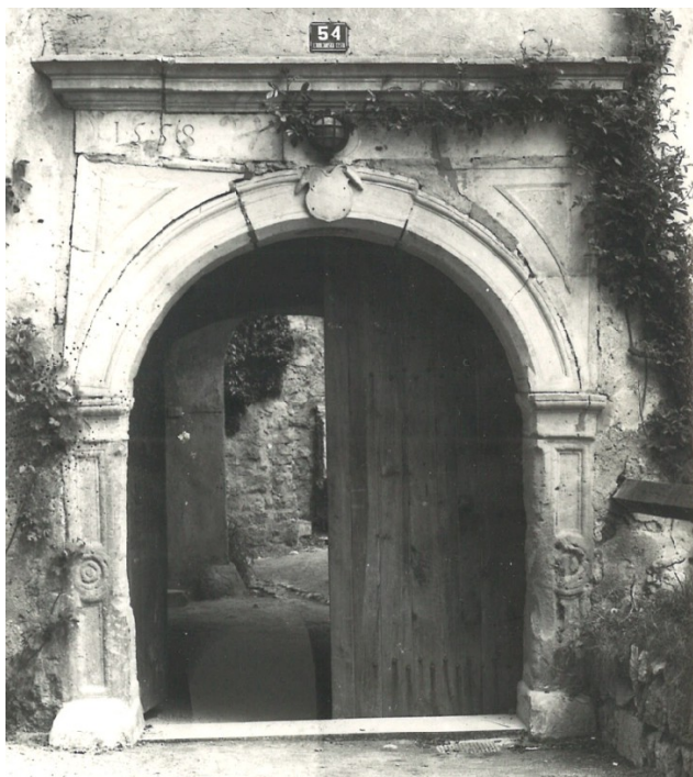
Foto Fonda, avgust 1973, ZVKDS OE Celje. Vhodni portal pred zamenjavo. Vratna krila niso obita s pločevino.
