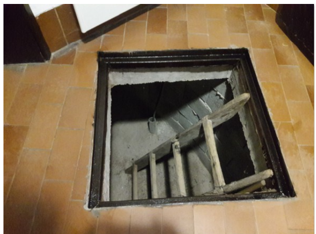
Medetaža je visoka 6 šar zidakov. Armiranobetonske plošče.
