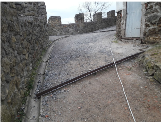
Od mostovža mimo okroglega stolpa: problematična izvedba pohodne površine z globokimi odvodi vode in betonskimi muldami – vizija: enotna utrjena peščena površina in tanke linijske kanalete
