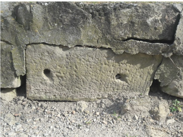
Spolija (okenski okvir z izvrtinami za kovinsko mrežo), uporabljena za zidec ob poti
