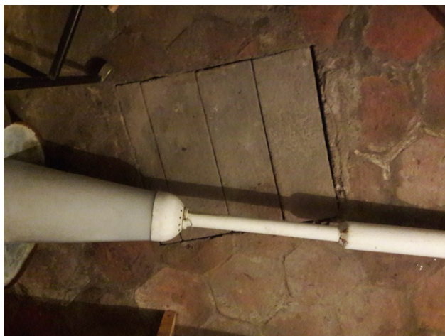
Vodomerni jašek in klinker tlak
