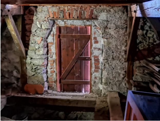
Vrata v zahodnem zatrepu
