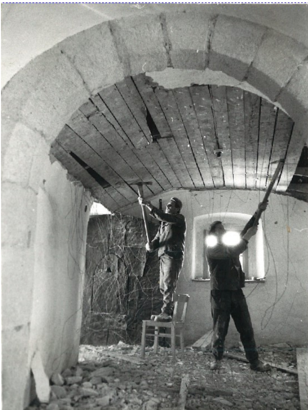
Odstranjevanje lažnega oboka na lesenem opažu v vhodni veži, 1969, foto Berk, ZVKDS OE Celje, neg. A-184/21 in 22
