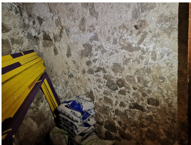
Široko fugiran prostor 2 – depo ob vhodni veži
