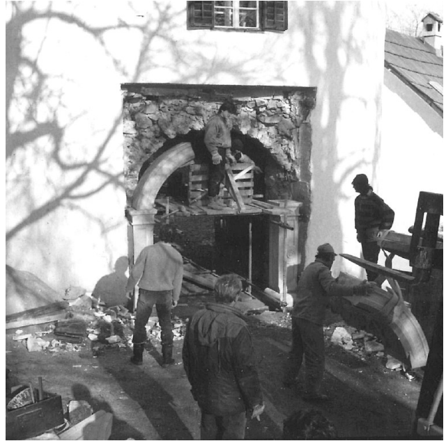
Detalji odstranjenega vhodnega portala, 18. 2. 1987, ZVKDS OE Celje, in montaža novega portala, 21. 12. 1990, ibid
