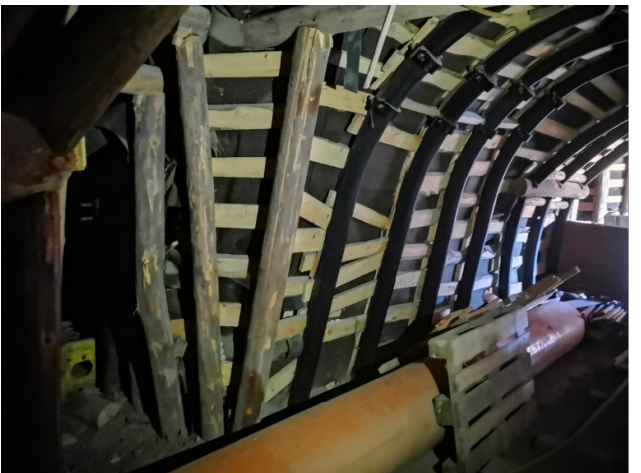
Osrednji del podporja na obeh straneh objema in povsem skriva par slopov, ki nosita oboke
