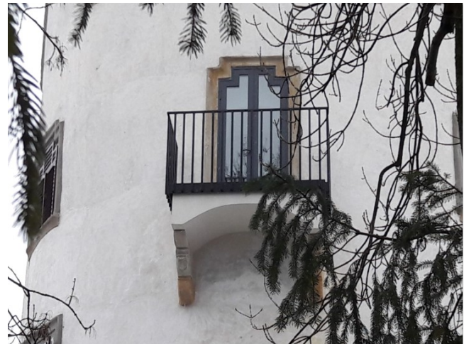
Balkon po prenovi.
