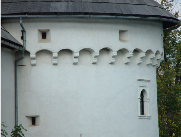
Ključasta strelnica (levo) je skrita za meteorno vertikalno.
