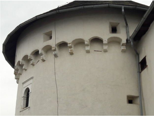
Obrambno nadstropje rondele na kamnitih konzolah, renesančno profilirano okno in strelna lina v smeri obzidja.
