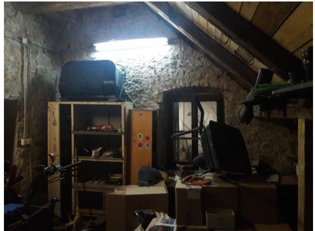
Delavnica / garaža, prostor 5
