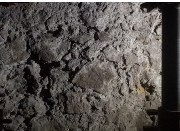
Zidava in fugiranje zaledne stene
