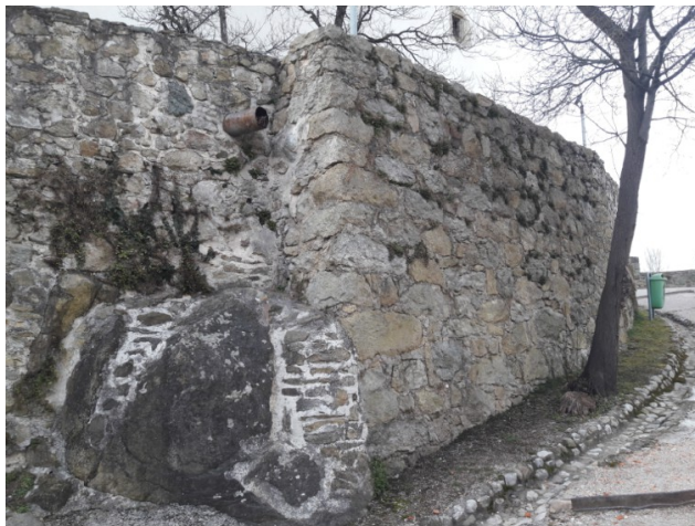
Zob v notranjem obzidju – dodatna ojačitev, druga gradbena faza?
