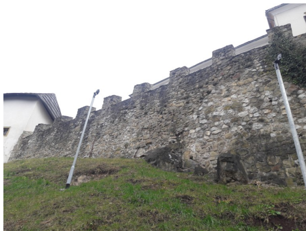
Severno obzidje – različne zidave / prezidave / plombe
