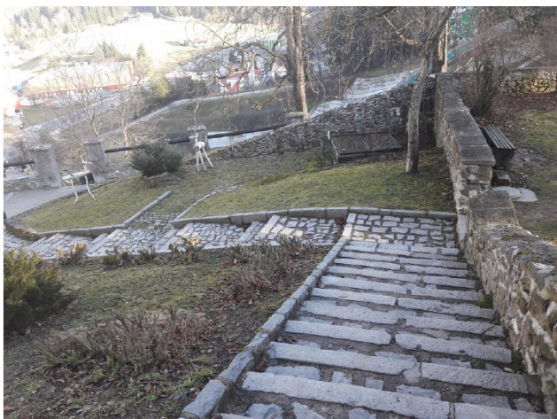
Pot od mostovža mimo zunanjega vodnjaka proti vhodu v grad – predvidna za sanacijo v sklopu prenove grajskega parka.
