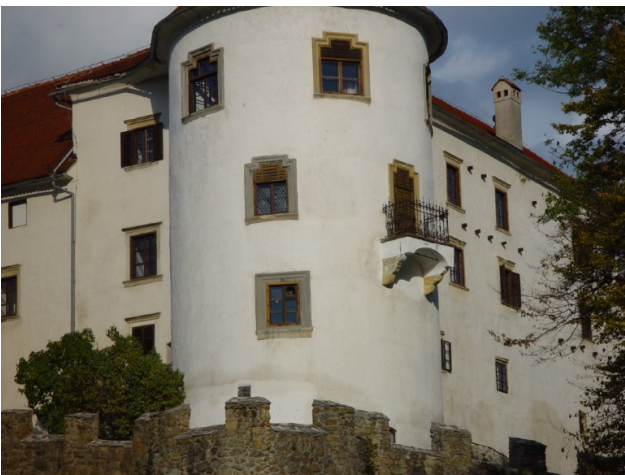
Stolp pred prenovo balkona in menjavo oken
