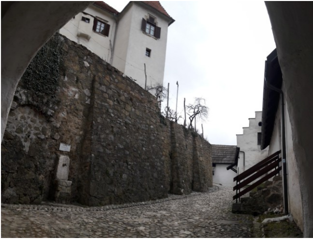
Medzidje, provizorična ograja stopnišča v sanitarije
