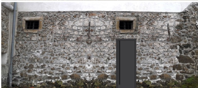
Sedanje stanje vhoda – označen je prelom zidu. Spodaj in desno variante sanacije stanja ob usposobitvi kleti.
