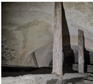
Prvi nosilni stlop, odvit iz strešne lepenke
