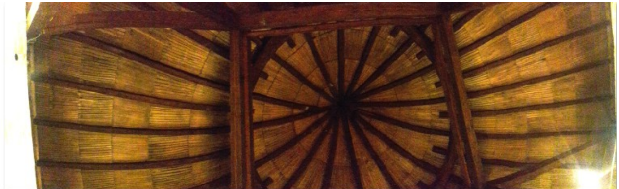
Ostrešje rondele, narejeno na novo ob obnovi
