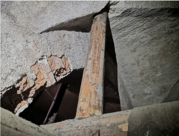
Preperela opeka nosilne oproge – potrebno je oboke skrbno in na gosto podpreti ter oprogo prezidati, kjer je vezivo dotrajalo.
