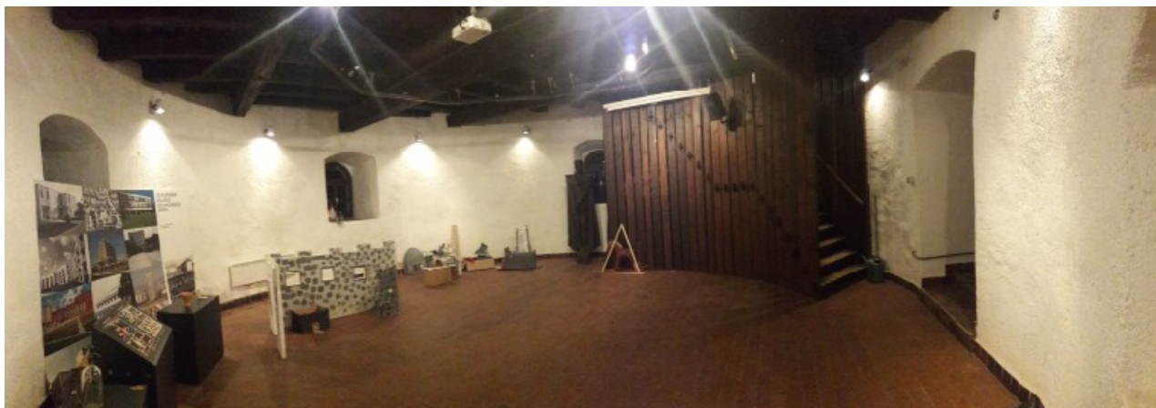
Rondela z recentnim stopniščem, prvotno samo lina z lestvijo. Neavtentičen dostop, zavajajoči vtis.
