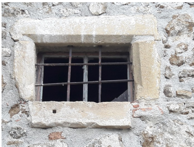
Kamniti okvirji okna imajo poznogotsko profilacijo (ajdovo zrno), vendar se vidi, da so kamni sekundarno zloženi na to pozicijo: profilacija preklade je predolga, prekratka polica ima luknjo za mrežo na sprednji strani.
