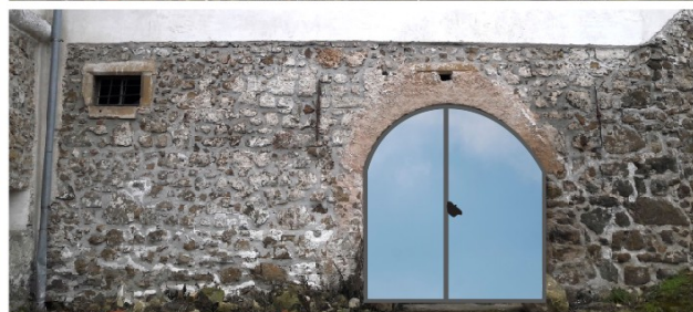
Sedanje stanje vhoda – označen je prelom zidu. Spodaj in desno variante sanacije stanja ob usposobitvi kleti.
