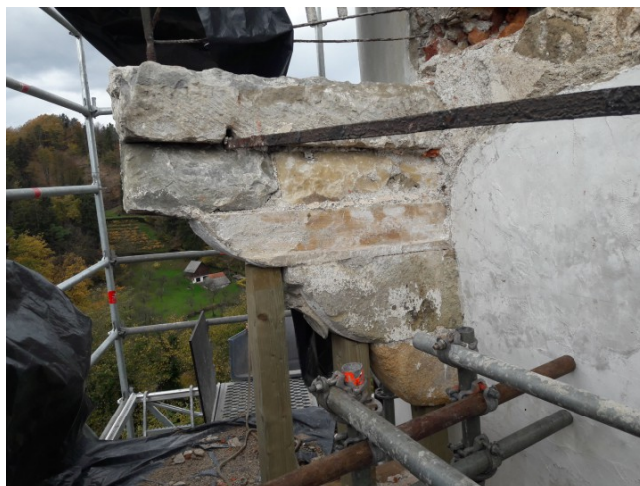
Po odstranitvi oboka se je pokazalo, da so konzole sestavljene iz po barvi in dimenzijah različnih sekundarno uporabljenih kosov kamna
