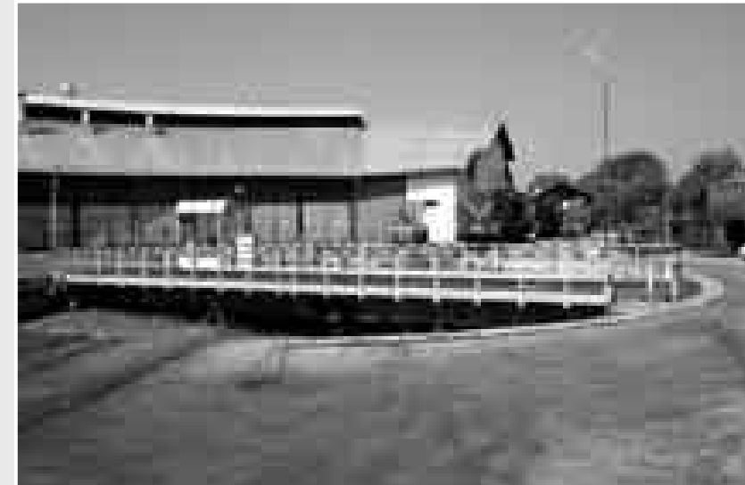
Foto 22: Pogled na okretnico s severovzhodne strani
