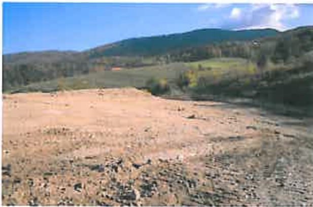
Slika 4: Planiranje zemljine ob novi ograji in urejanje brežine
