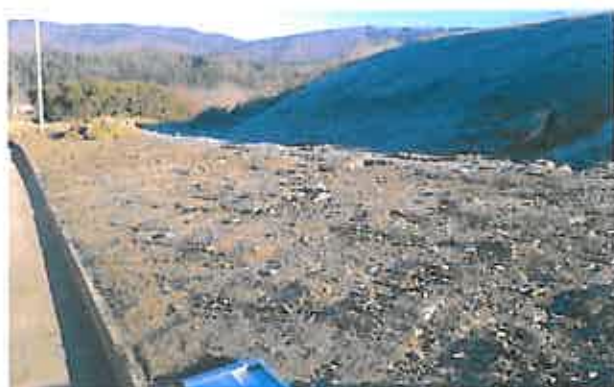
Slika 6: Vkopane plinske cevi -menjava 285,5m ograde;
